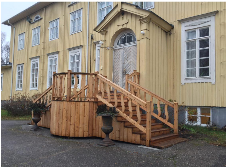
Kuva 32. Portaat pääoven edustalla
